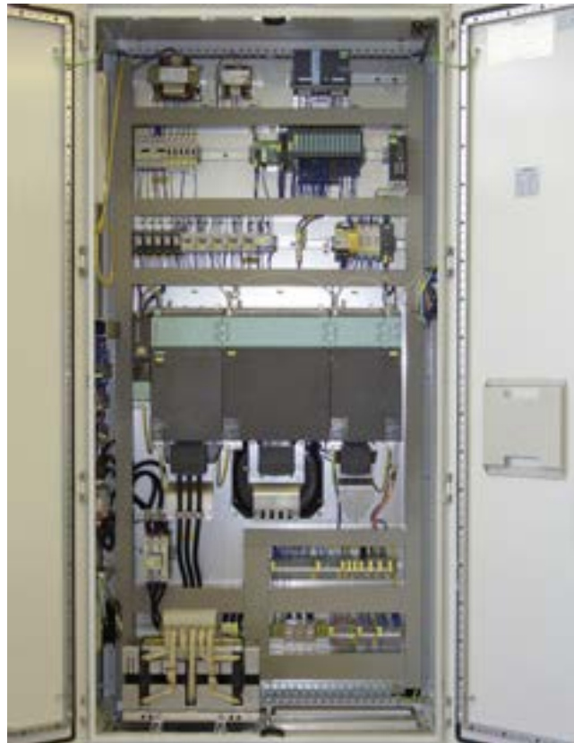
配备 SINAMICS S120 书本型模块的控制柜
